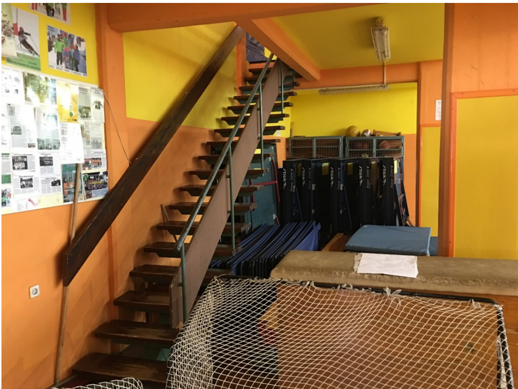
STOPNIŠČE, KI POVEZUJE PRITLIČJE TELOVADNICE IN GALERIJO
