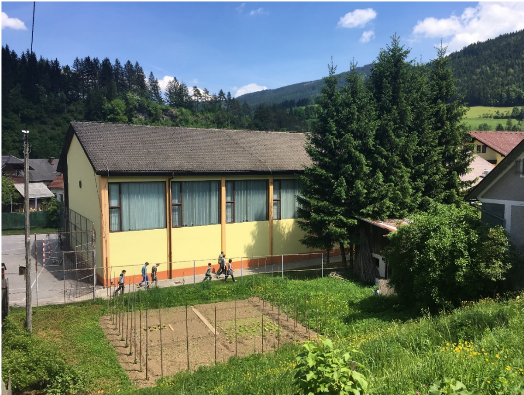
POGLED NA JUŽNO FASADO
