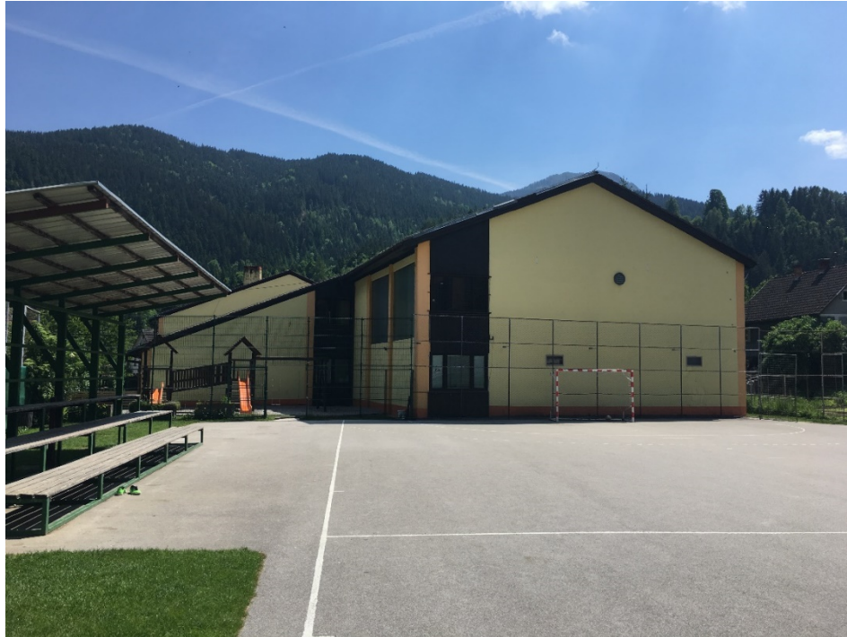
POGLED NA SEVERNO FASADO
