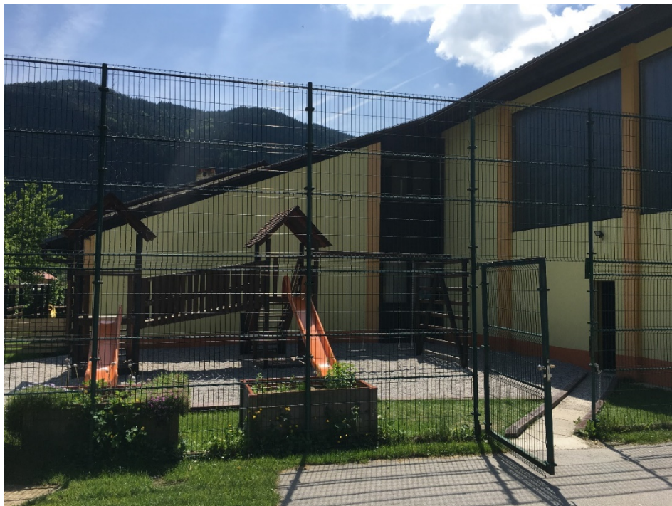
POGLED NA SEVERNO FASADO, IGRIŠČE VRTEC
